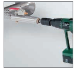
Anbohren unter Druck mit der CS Bohrvorrichtung
