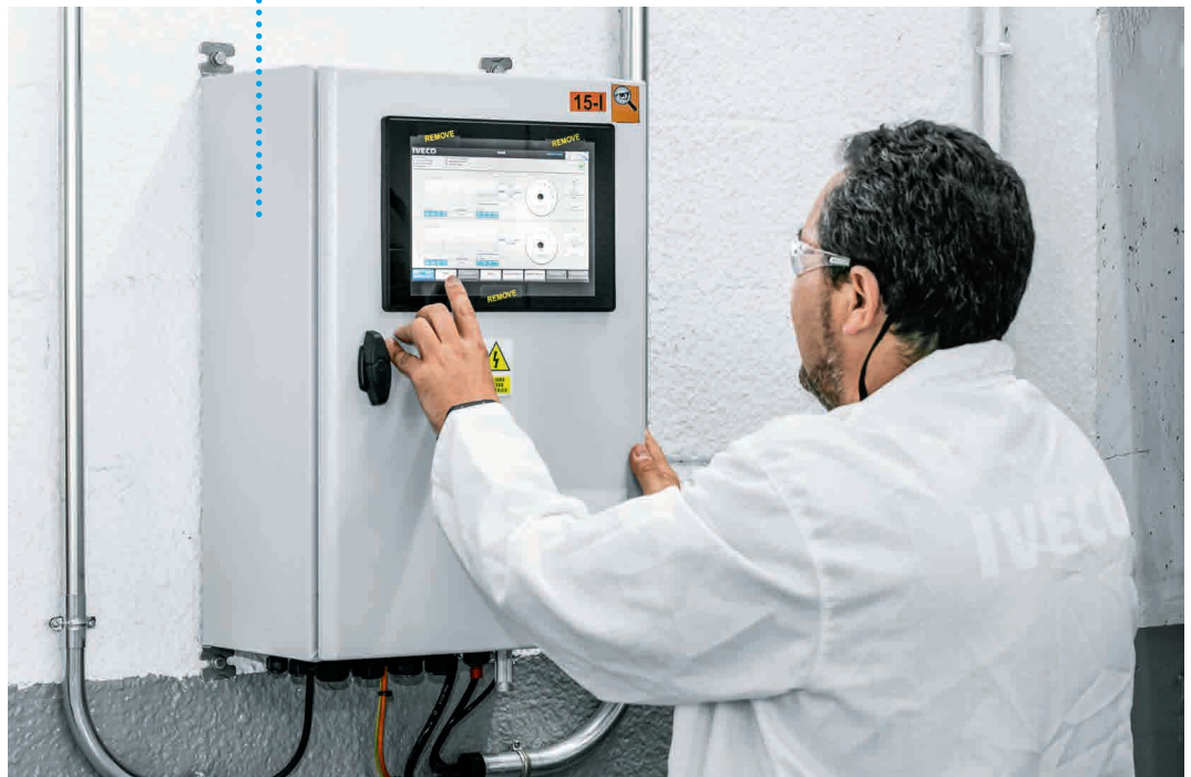
Kompakt gebaut , passt das Energie-Effizienz-Modul in den ATEX-Schutzschrank. Bedient wird es per Touchscreen, Smartphone oder Tablet.
